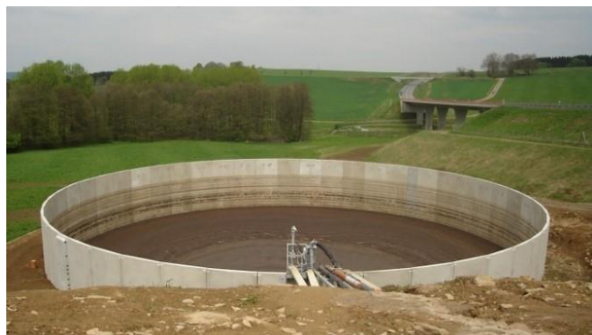
Reservatório de chorume. Fonte: IAK
